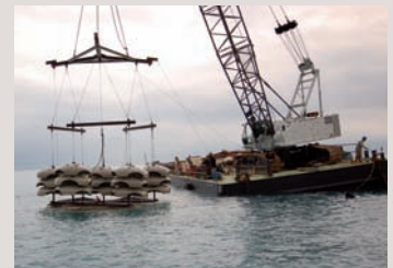
→ Pose de récifs avec une barge au large de Cagnes-sur-Mer.
